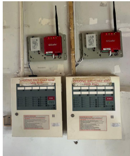
Hình 4: Một số hình ảnh lắp đặt G6 thực tế
